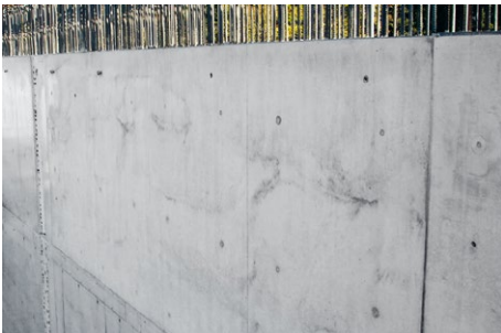
Abb. 31: Beispiele für glatte, geschlossene Oberfläche mit Hell-/Dunkelverfärbung
