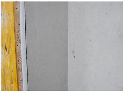
Abb. 40: Beispiel Arbeitsfuge (Wand)
