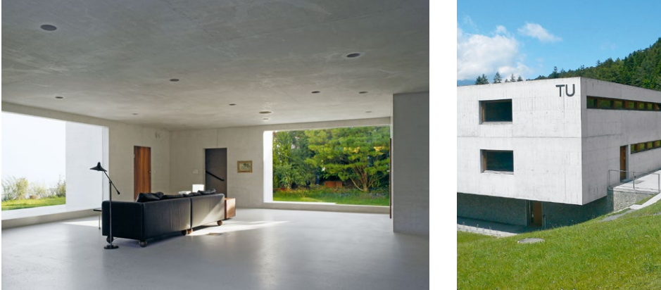
Abb.35: Beispiele für Sichtbetonbauten mit hohen Anforderungen an die Ebenheit
