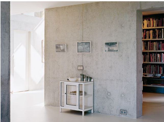
Abb.54: Beispiel für BOK 1 (kein Sichtbeton)
