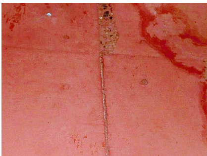
Abb. 51: Abgeschliffener Versatz
