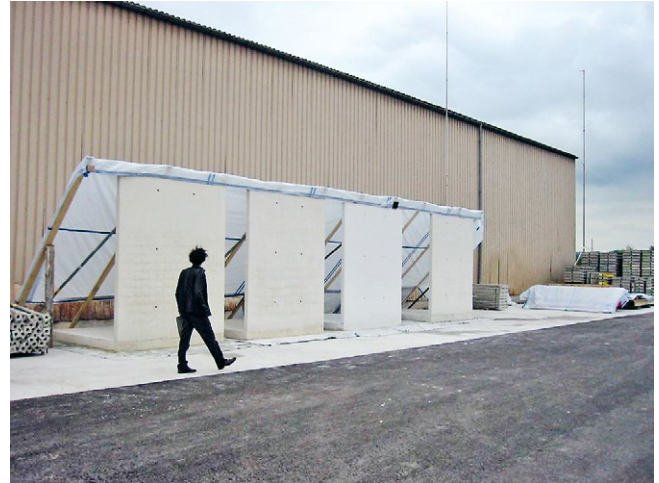
Abb.48: Beispiel von vier Musterelementen (Ansichtsflächen) für Betonauswahl
