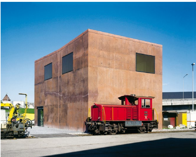
Abb. 58: «Rostiger» Beton (Foto: Stellwerk Vorbahnhof Zürich, Gigon/Guyer Architekten, Zürich)
