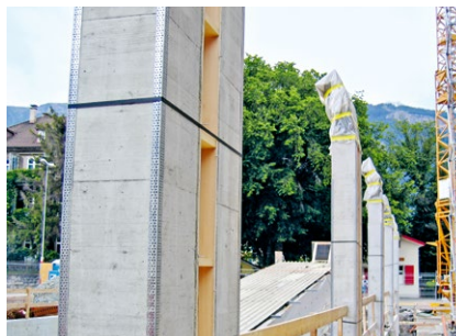
Abb. 41: Kantenschutz Stützen (scharfe Kanten)
